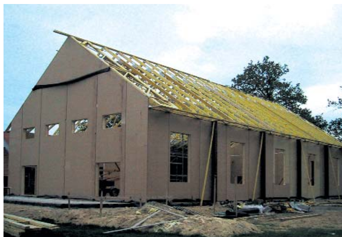
... Holzrahmen- und Nagelplattenbinder-Bauweise deutlich günstiger als konventionelle Objekte
