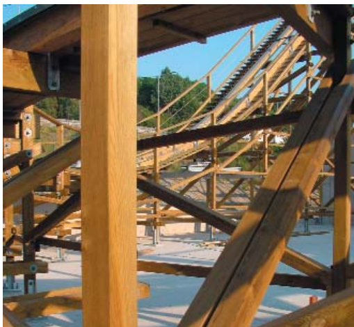
1200 m 3 Kesseldruck imprägniertes S13 aus der Lüneburger Heide, abgebunden und mit ...
