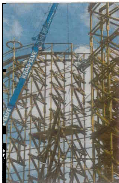
Derzeit wird in Göteborg montiert.
