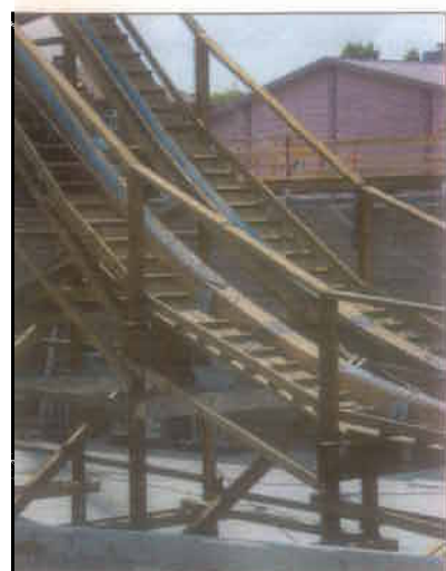
In Teilstück der Bahn am Ende des 5 Meter hohen ersten Ablaufberges: Kiefer aus Furnierschichtholz mit etw.
