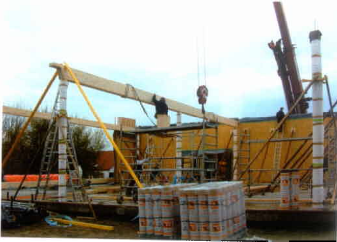
Bild 9: Aufbau der Ausstellungshalle. Mittelpfette mit auskragender Ausklinkung.
