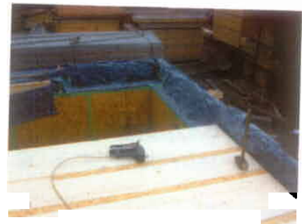
Bild 7: Unteres Geschoss des Verwaltungsgebäudes während der Montage der Brettstapeldecke
