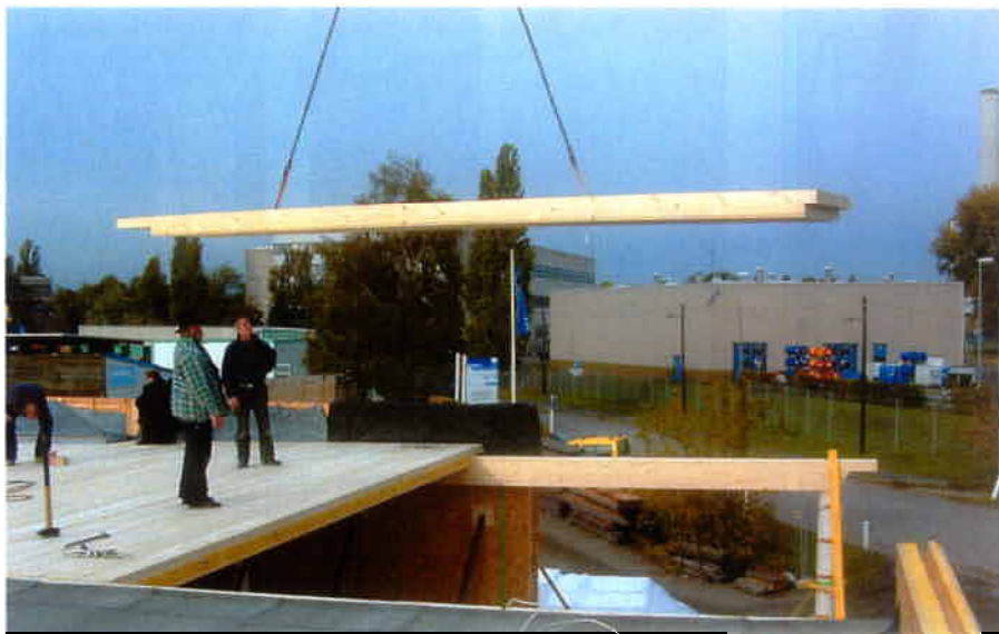
Bild 12: Dachelement der Ausstellungshalle mit Massiv-Einleimern am Auflager: Ausklinkung (rechts) und Auskragung (links).
